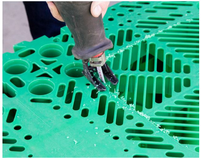
Kuva 11. Saha aukko nousuputkimuhville
