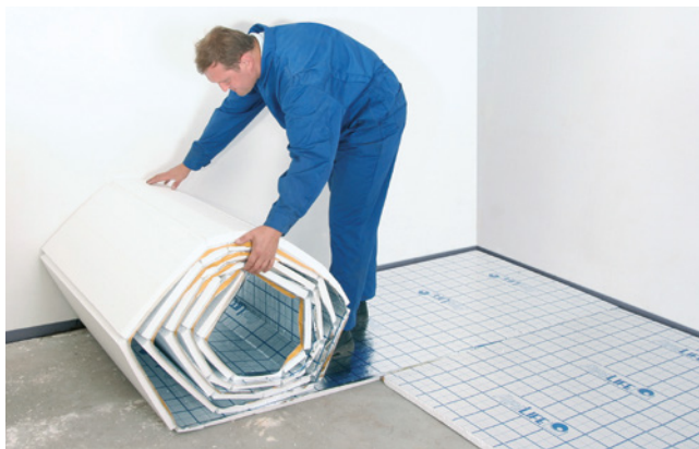
Układanie płyt polistyrenowych.
