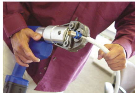
4. Umieszczenie kształtki w szczękach prasy radialnej.
