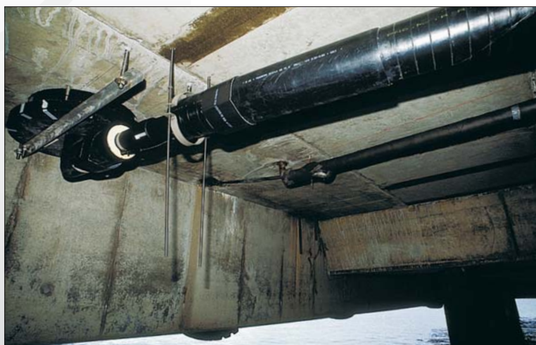
Vestfold, motorvägsbro med Isovarm dagvattenledning
