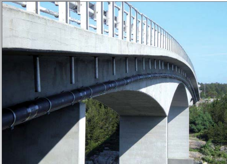
Ulvesund i Øygarden Isovarm rörledning
