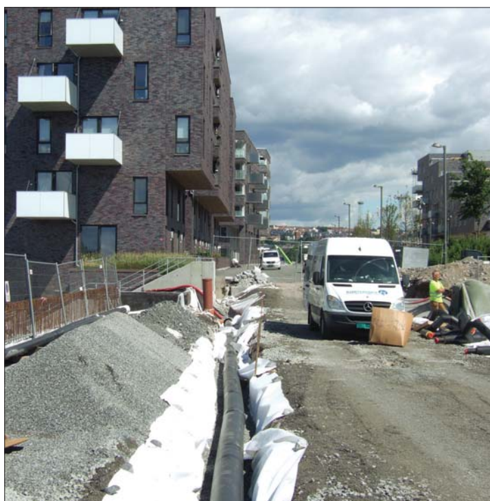
Isovarm som både vatten og avloppsledning for større projekt på Sørenga i Oslo
