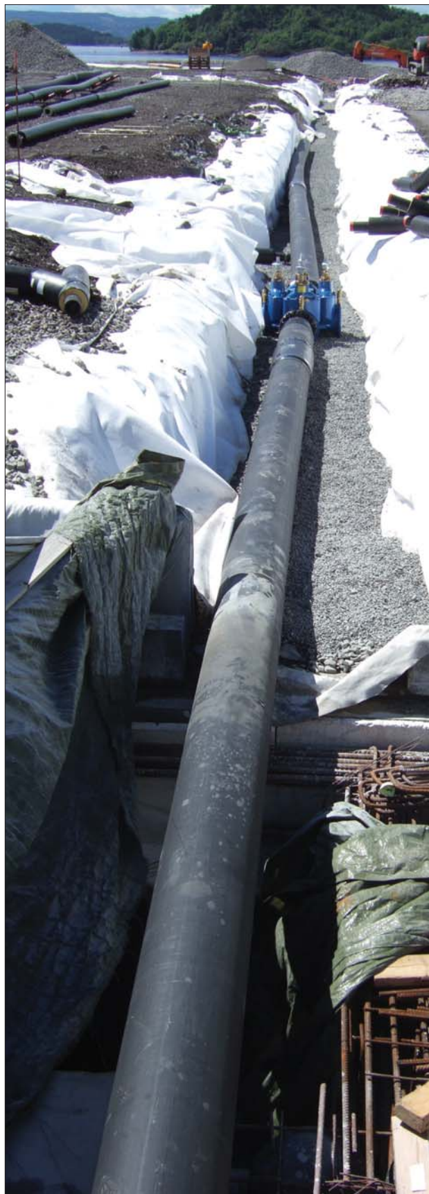
Isovarm som både vatten og avloppsledning for større projekt på Sørenga i Oslo
