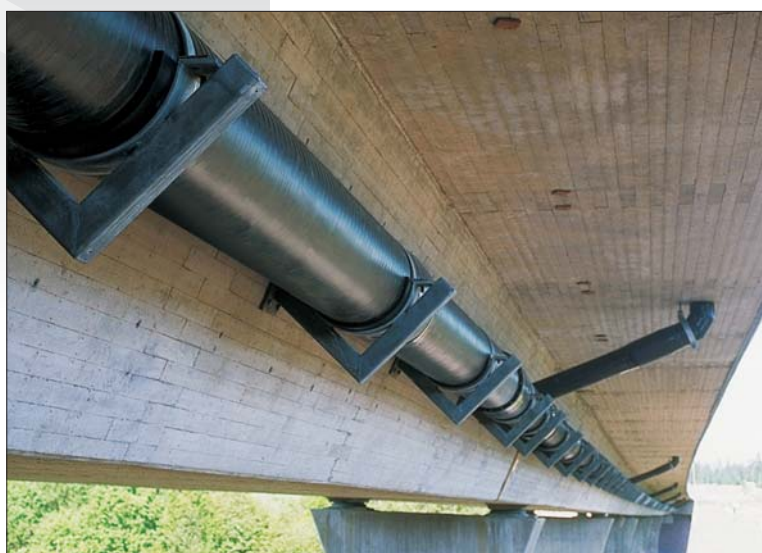
Vestfold, motorvägsbro med Isovarm dagvattenledning
