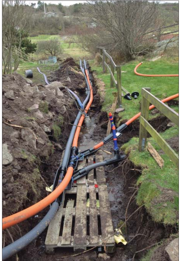
Exempel på Isoterm vatten och tryckavlopp i grunda schakter: Alnö, Sundsvall
