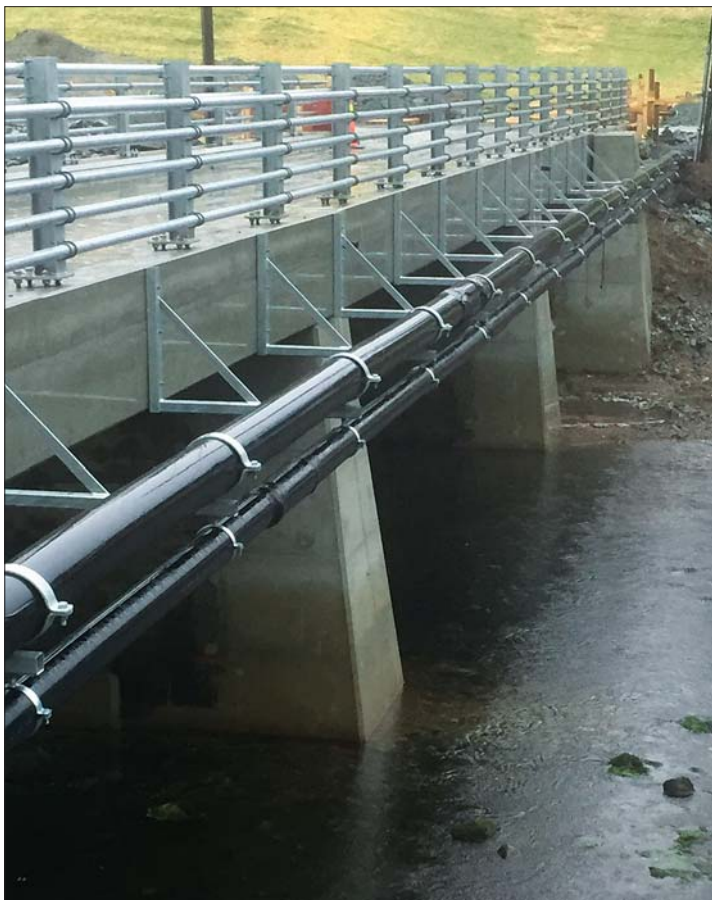
Överföringsledning för vatten och avlopp, Tømmernes bro, Os Kommune
